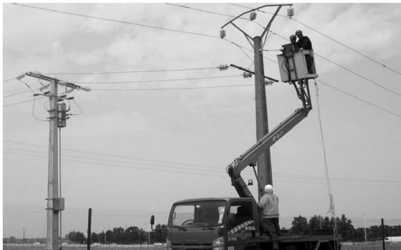
des zones côtières, ce qui impacte négativement leur fonctionnement, selon la même source. Pour éviter le courant de fuite qui peut provoquer des pannes et protéger les isolateurs et équipements contre l'usure, Sonelgaz-Transport de l'électricité et opérateur du système a mobilisé tous "les moyens humains et logistiques nécessaires, à savoir 58
